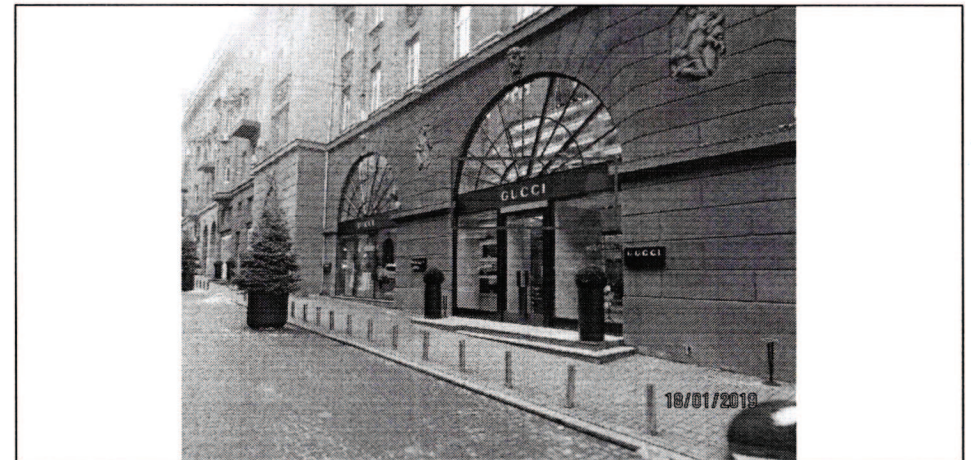
Фото фіксація розміщення спеціальної тимчасової/стаціонарної конструкції:
