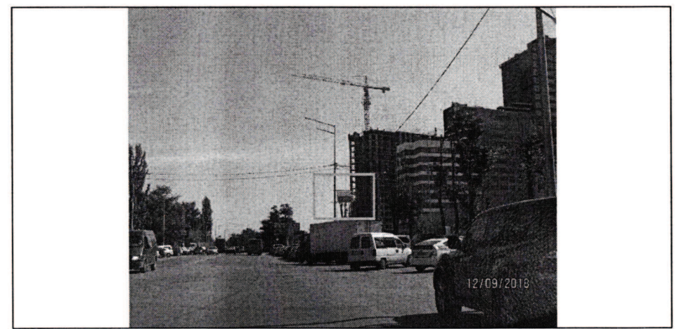
Фото фіксація розміщення спеціальної тимчасової/стаціонарної конструкції:
