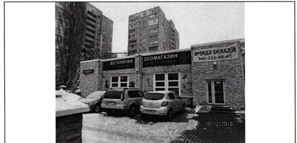
Фото фіксація розміщення спеціальної тимчасової/стаціонарної конструкції:
